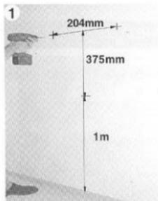
Pointer les 3 trous de fixation et placer les 3 chevilles
